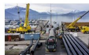
Stadtentwässerung CHF 44.2 Mio.
