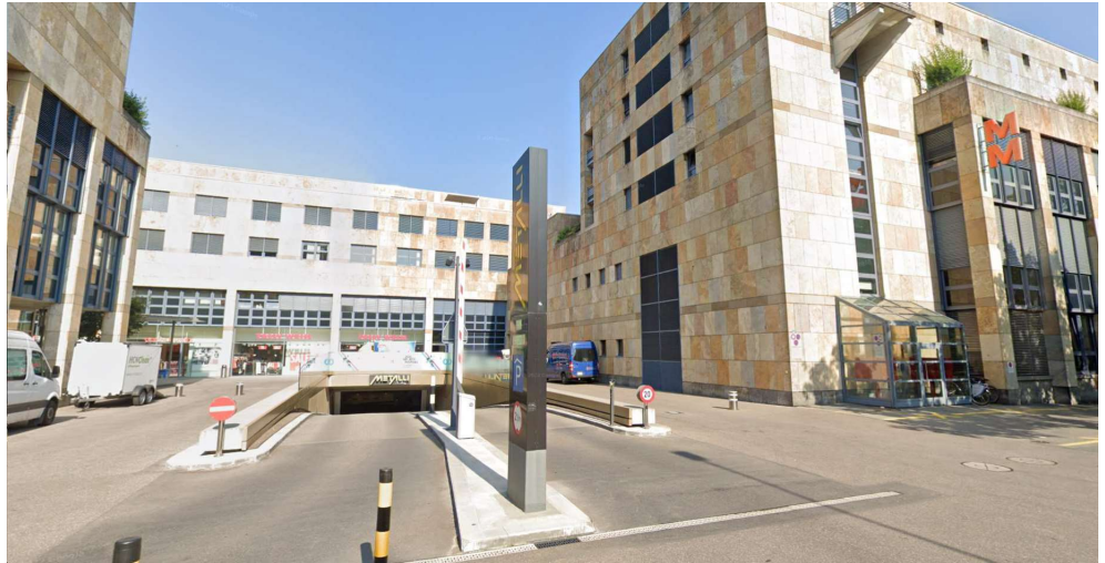
Abbildung 11: offene Rampe Tiefgarage Metalli
