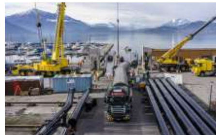
Stadtentwässerung CHF 29.15 Mio.
