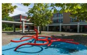
Schulhaus Herti Neubau CHF 66.29 Mio. Sanierung CHF 22.8 Mio. Provisorien CHF 14.2 Mio.
