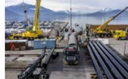
Stadtentwässerung CHF 3.3 Mio.
