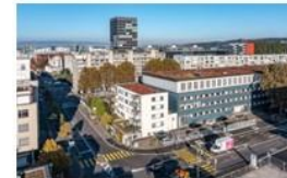
Industriestrasse Sanierung und Verkehrsberuhigung CHF 2.2 Mio.
