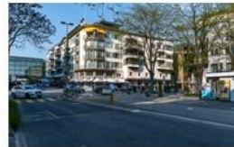
Alpen- und Gotthardstrasse Sanierung und Neu- organisation CHF 1.3 Mio.
