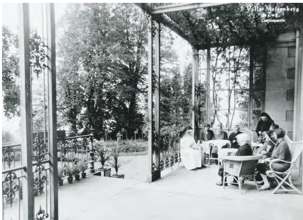
Abb. 8: Die Veranda auf der Ostseite der Villa vor dem Anbau des Speisesaals, um 1930. 22
