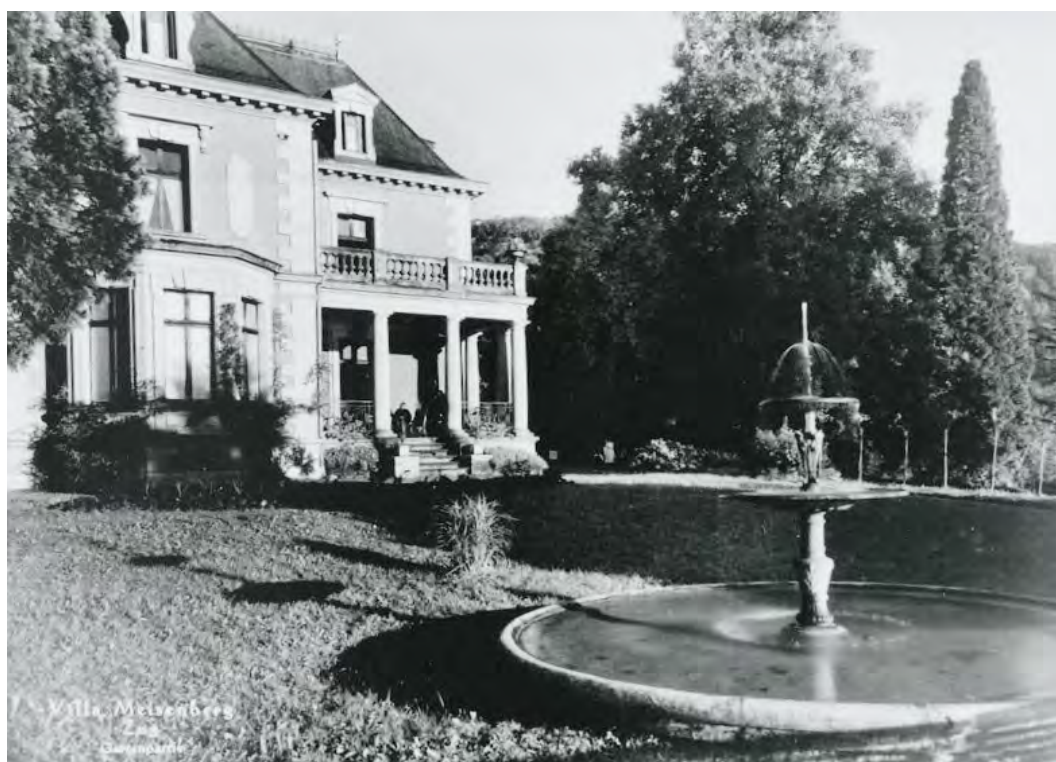
Abb. 6: Brunnenschale vor der Südfassade der Villa, um 1930. 20
