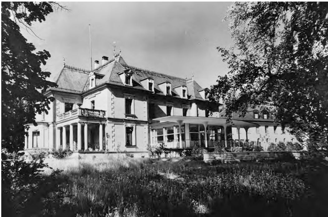
Abb. 17: Terrassenanbau der Südseite, um 1950. 33
