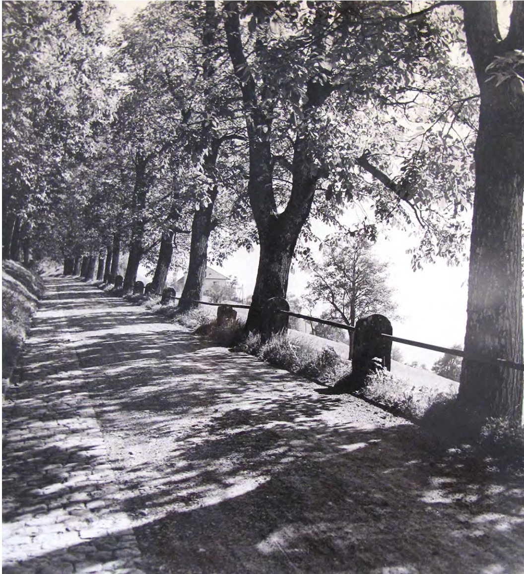
Abb. 12: Die Meisenbergstrasse als Nussbaumallee um 1930. 26
