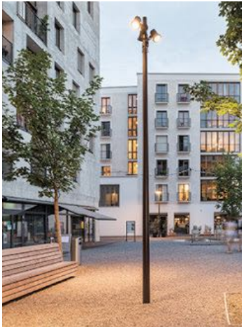
Referenz Beleuchtung Neuco, Masten mit Strahlern unterschiedliche Grössen für Gassen und Höfe
